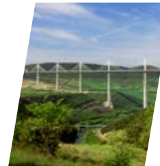
Viaduc de Millau
